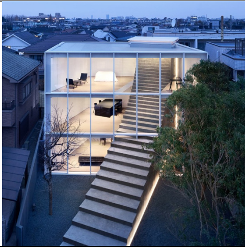
13. Casa Puente por Nomo Studio: https://www.metalocus.es/es/noticias/desglosar-el-programa-en-poliedros-casa-puente-por-nomo-studio
