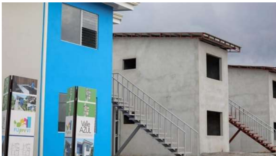
Ilustración 4.3 Viviendas De Dos Niveles Construidas Con Ecoblock I
