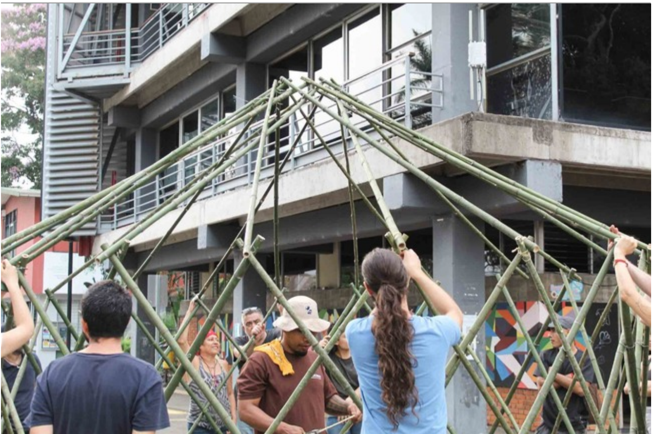
Montaje de la yurta a las afueras de la Escuela de Arquitectura. Fotografía: Francis Pérez.
