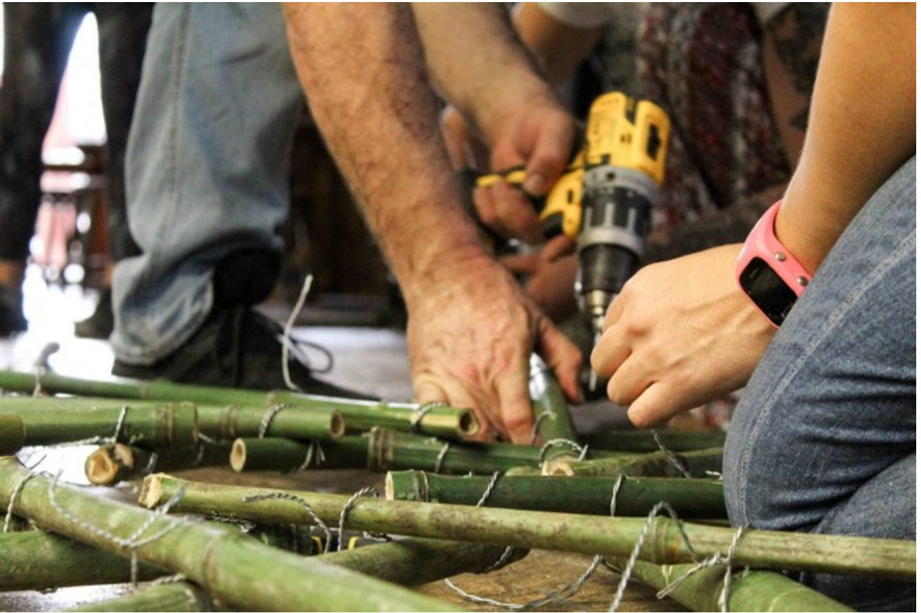
Amarres de la cubierta con taladro. Fotografía: Francis Pérez.
